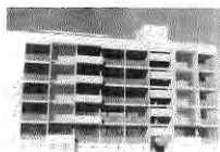
1962.- Edificio Lanahue, Concepción, con E. Duhart H.
