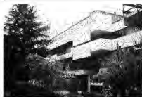
1968.- Edificio Remodelación Catedral, Concepción, con R. Jofré y L. Soto.
