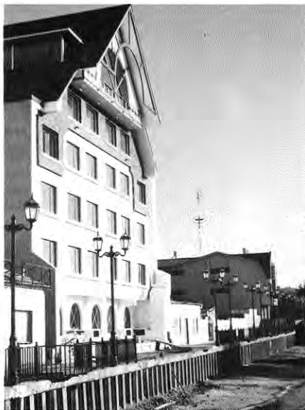
Hotel Finis Terrae y Hotel Tierra del Fuego, vista oriente (desde puente calle Magallanes)
