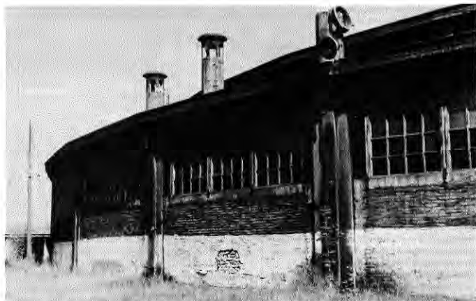
• Exterior Casa de Máquinas.
