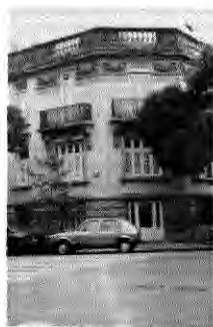
• Fig. 10. Casa de Esquina, Arqto. J. G. de la Lama 1913, Tonallá 52.
