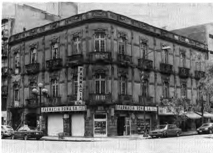
*Fig. 18. Edificio de Departamentos. Alvaro Obregón 110. Ing. Marco Rivera Calzavayud - 1919 - (Foto: Jorge Contreras).
