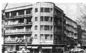
*Fig. 22. El Racionalismo en Esquina. Edificio Depos. A. Obregón 85, Esq. Córdoba.
