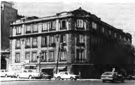
*Fig. 19. Edificio Francia - 1920.
