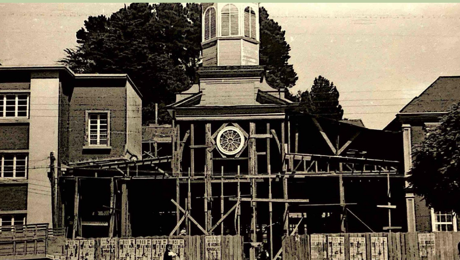
Figura 0. Fachada iglesia en reparación, 1962. Fuente: Castro Fones y Brauning Salazar (2022).
