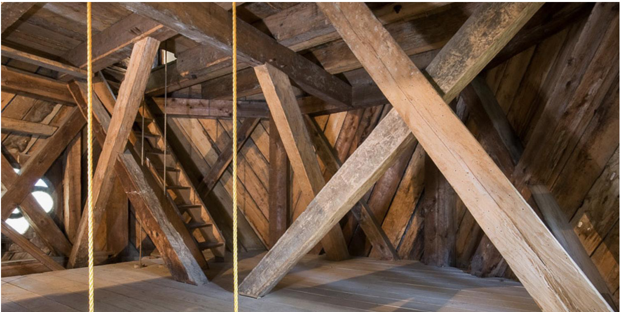
Figura 14. Estructura campanario con avistamiento de unión junta de rebajo, y utilización de tarugos. Fuente: Oficina Plan Arquitectos.
