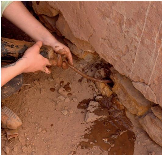
Figura 6 Inyección de mortero de barro en sobrecimientos. Fuente: Fotografía de las autoras.
