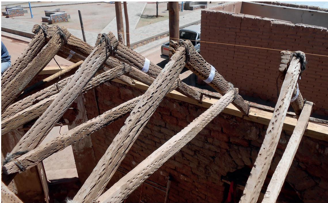
Figura 8 Reconstrucción de las tijeras (imagen superior) y guayado (inferior). Fuente: Fotografía de las autoras.
