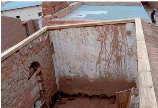
Figura 7 Colocación de viga de encadenado superior de madera. Fuente: Fotografía de las autoras.
