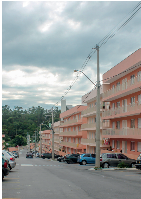
Figura 7 Jardim São Camilo . Nuevos bloques para albergar a los habitantes removidos por la urbanización del asentamiento, que está ubicado tras los árboles. Fuente: Fotografía de Patrícia Samora, 2017.
