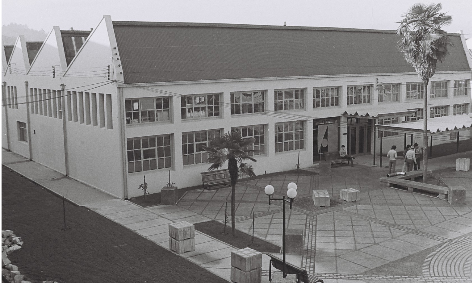
Figura 1. Edificio de la Escuela de Arquitectura, Universidad del Bío-Bío. Fuente: Archivo.
