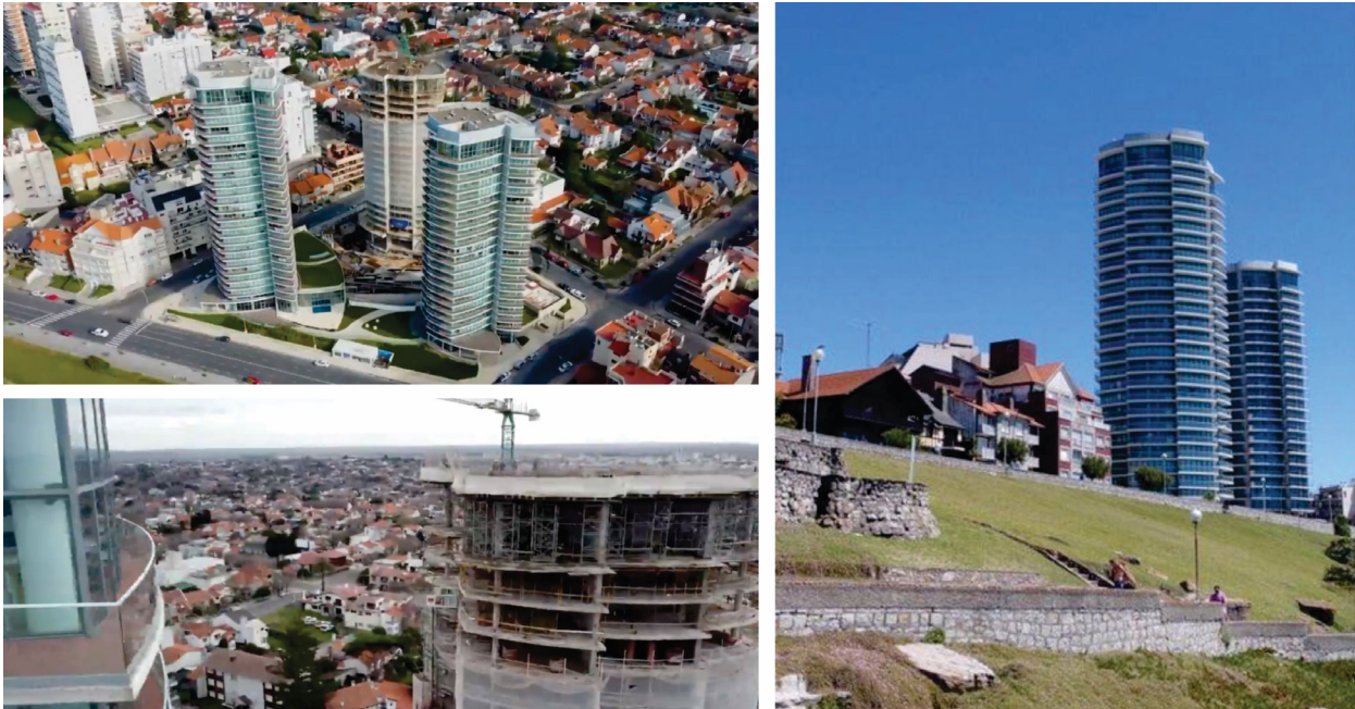
Figura 5 Selección de una intervención en altura, costera, proyectada por un arquitecto reconocido internacionalmente dentro del barrio Stella Maris. Obsérvese el tejido residencial y paisajístico lindero. Fuente: Fotografías y capturas de video de promoción inmobiliaria y de la constructora interviniente ( https://www.maralexplanada.com.ar/ , https://www.youtube.com/user/MaralExplanada y https://www.imasaconstructora.com/obra/maral-explanada ).
