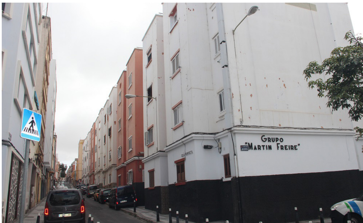
Figura 1. Imagen perteneciente al conjunto de 1472 viviendas del Grupo Martín Freire, Schamann, Las Palmas de Gran Canaria. Fuente: Fotografía del autor.
