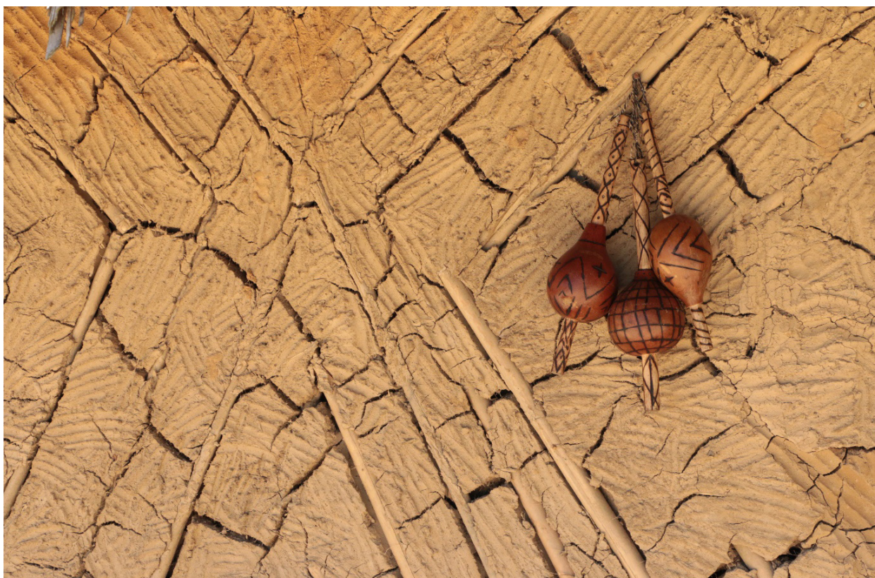
Figura 4. Detalhe da parede da opy do Tekoá Vy'a. Detalhe da parede da opy do Tekoá Vy'a, em terra crua de tonalidade clara, devido à proximidade com o litoral. Podem ser observadas as marcas deixadas pelos dedos que alisaram a parede, uma característica do processo construtivo tradicional guarani. Fonte: Zanin, 2021.
