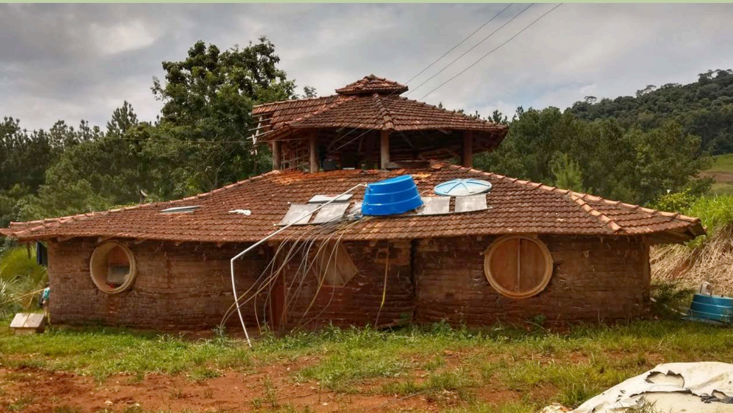
Figura 0. Residência construída com paredes de terra encxada e pau a pique. Fonte: Projeto Arq. César Costa, foto de Cecília Prompt.
