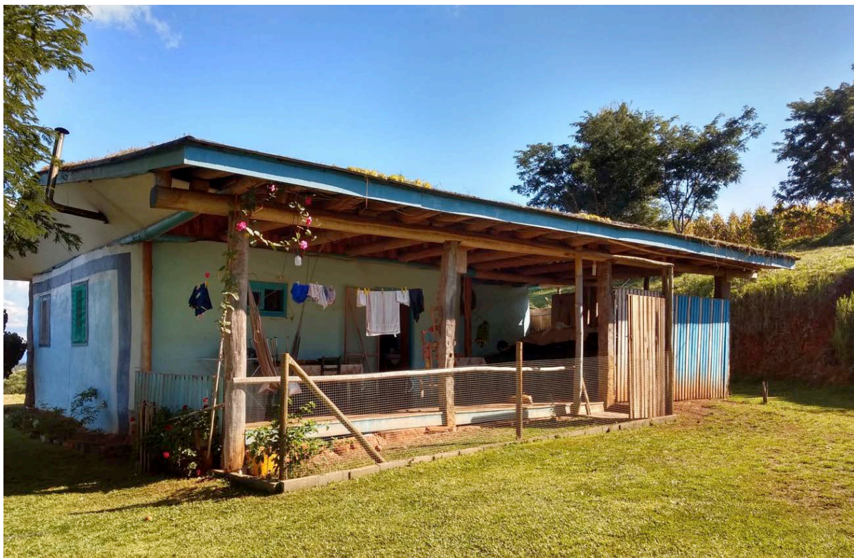
Figura 4. Residência construída com terra ensacada e cobertura ajardinada. Fonte: Projeto Arq. Silvio Santi, foto de Cecília Prompt.
