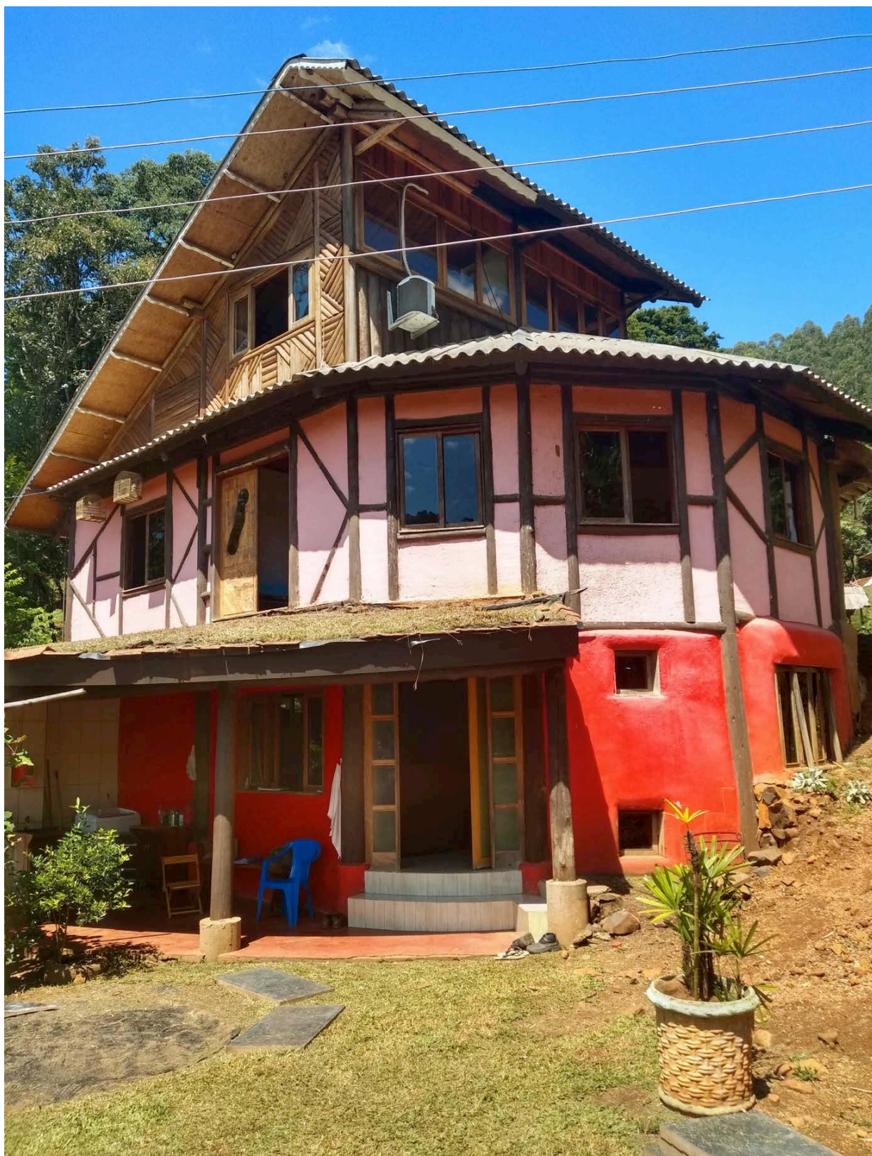
Figura 9. Residência construída com estrutura de madeira, paredes de pau a pique e terra encacada e cobertura ajardinada. Fonte: Projeto Arq. Cecília Prompt, foto de Cecília Prompt.
