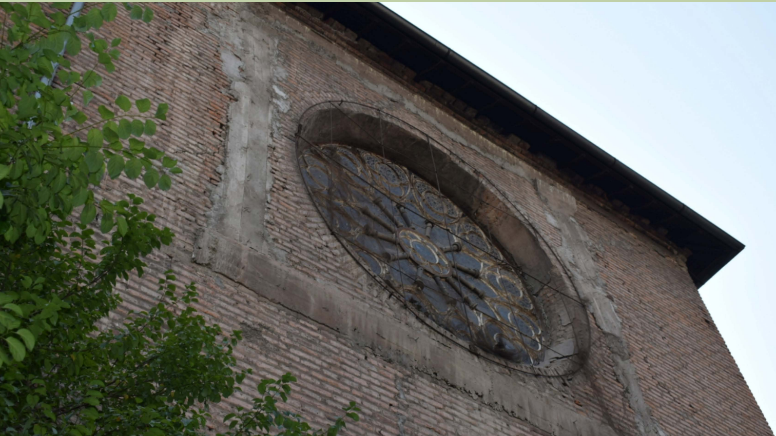
Figura 0. Confinamiento en rosetón de fachada oriente de Iglesia de Santa Filomena. Fuente: Elaboración de los autores.
