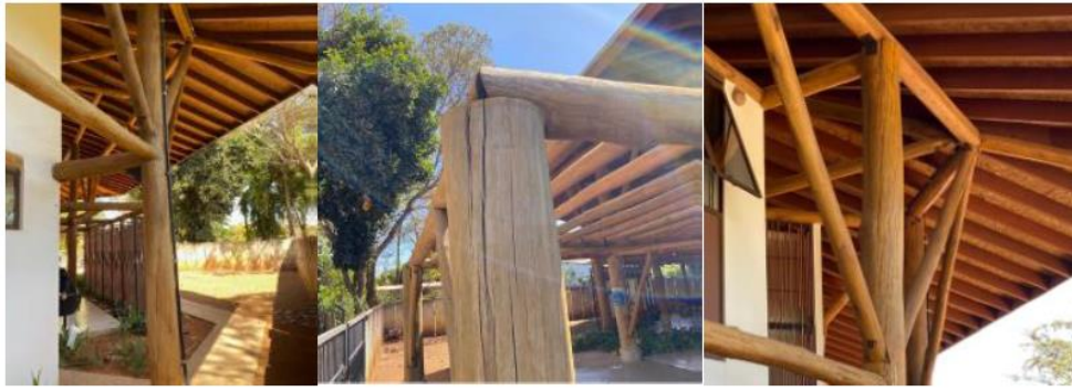
Figure 3: Photos taken of the Maloca's columns (Laboratório de Reabilitação do Ambiente Construído 2022).
