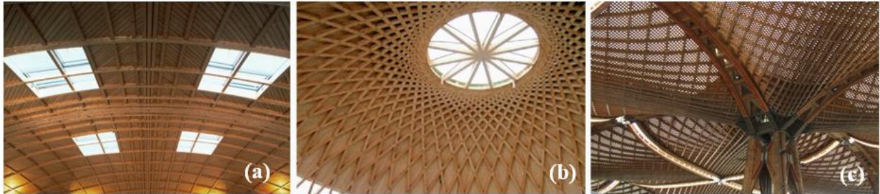
Figura 3: (a) Gridshells deformadas elásticamente construidas siguiendo el método desarrollado por Julius Natterer. Polydôme (Lausane, 1991) Julius Natterer; (b) Centro de terapia equina (Suiza, 2004) Julius Natterer; (c) Expodach (Hannover, 2000) Julius Natterer.
