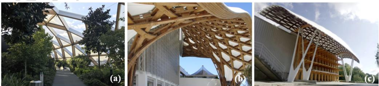
Figura 1: Clasificación de estructuras laminares de madera atendiendo al tipo de elemento usado en su construcción. (a) Elementos rectos: Crossrail Place (UK, 2015) Foster and Partners. Fuente: Bex.Walton (CC BY 4.0). (b) Elementos precurvados: Centro Pompidou Metz (Francia, 2010) Shigeru Ban Architects. Fuente: dalbera (CC BY 4.0). (c) Elementos deformados elásticamente: PEMADE gridshell (España, 2017) A. Lara y M. Guaita.
