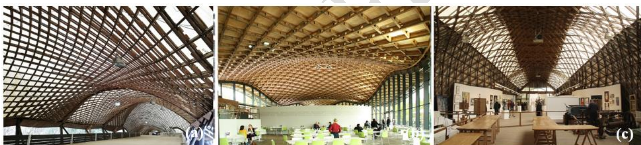
Figura 2: Gridshells deformadas elásticamente construidas siguiendo el método desarrollado por Frei Otto. (a) Mannheim Multihalle (Alemania, 1975) Frei Otto y Arup ; (b) Savill Garden (UK, 2006) Glen Howells y Buro Happold; (c) Weald and Downland Living Museum (UK, 2002) Edward Cullinan y Buro Happold.
