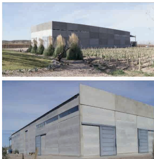
Figuras 4. Bodega H. Fotografías.
