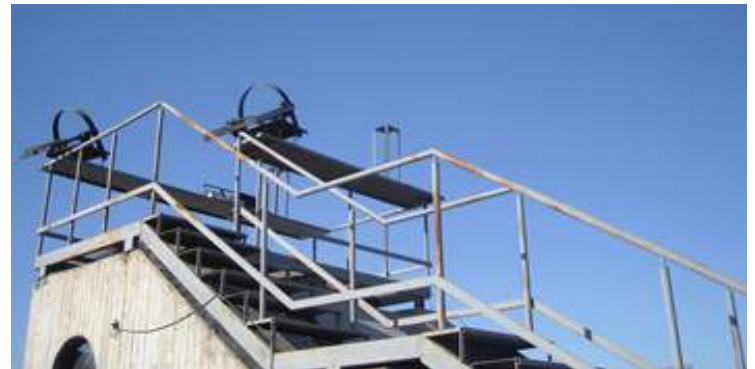
Figura 2. Estación de medición de iluminación natural del Instituto Nacional de Ambiente, Hábitat y Energía (INAHE), ubicado en el Centro Científico y Tecnológico Mendoza (CCT Mendoza). Fuente: Fotografía del autor.
