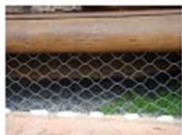
Possíveis medidas construtivas para afastar as peças de madeira do solo
