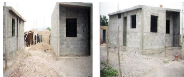
Figura 10: Situación de viviendas con fachadas "vistas". Fuente: Elaboración Propia.
