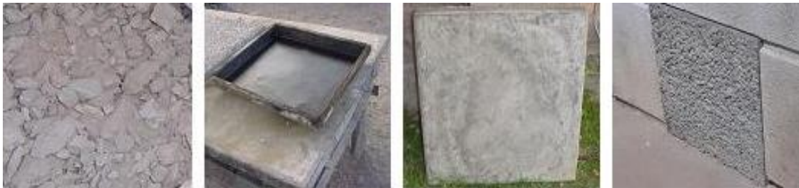
Figura 9: Proceso de fabricación y terminación de la capa externa. Fuente: Elaboración Propia.
