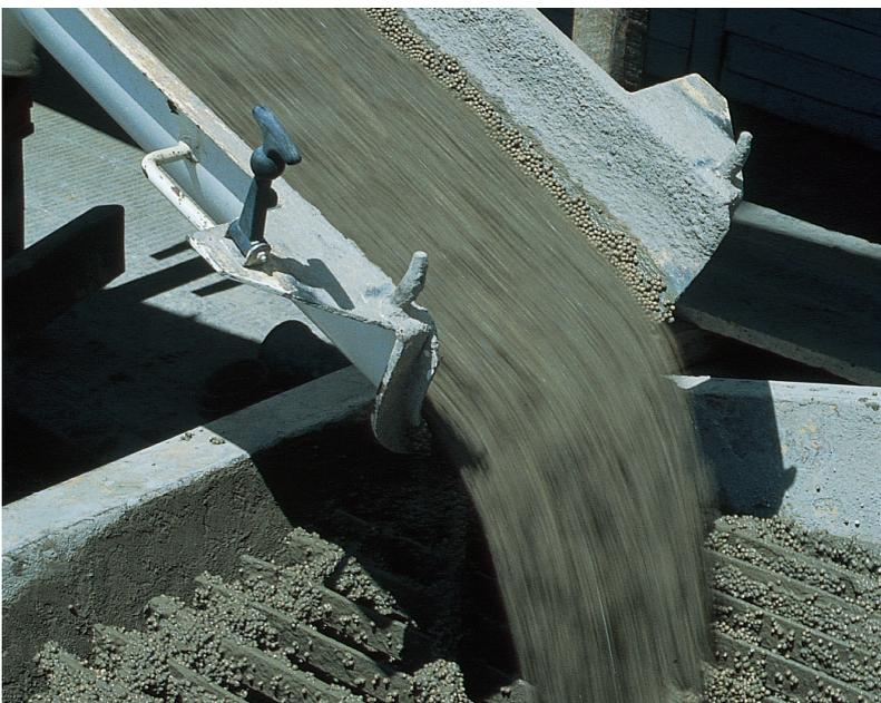
Fig. 3 Hormigón premezclado con alta fluidez.
