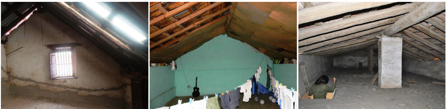
Figura 5. Tapancos en áreas urbanas de Querétaro. Fuente: Elaboración de los autores.
