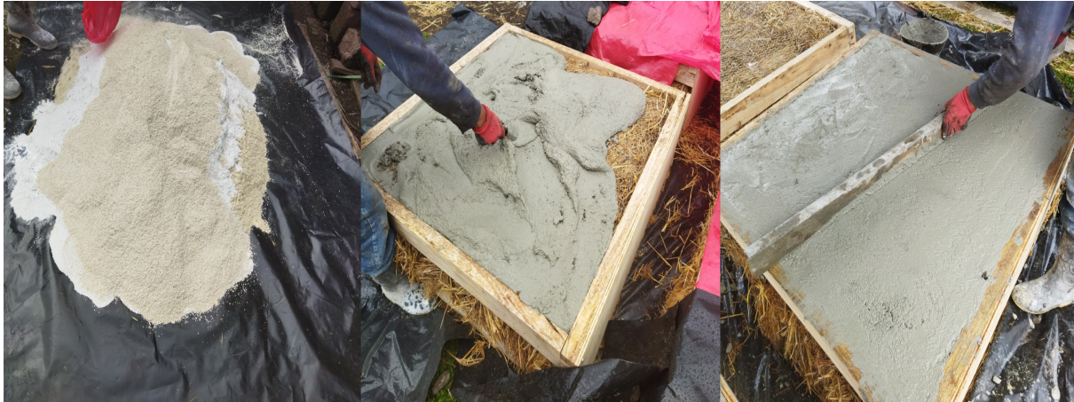
Figura 11. Aplicación en paneles del mortero elaborados con la mezcla 5050AM2. Fuente: Elaboración de los autores.
