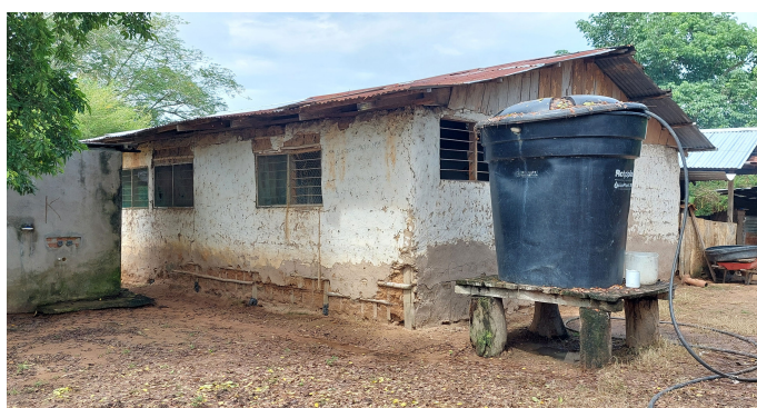
Figura 14. Casa tradicional rural bahareque embutido, La Zapatos. Fuente: Elaboración de los autores
