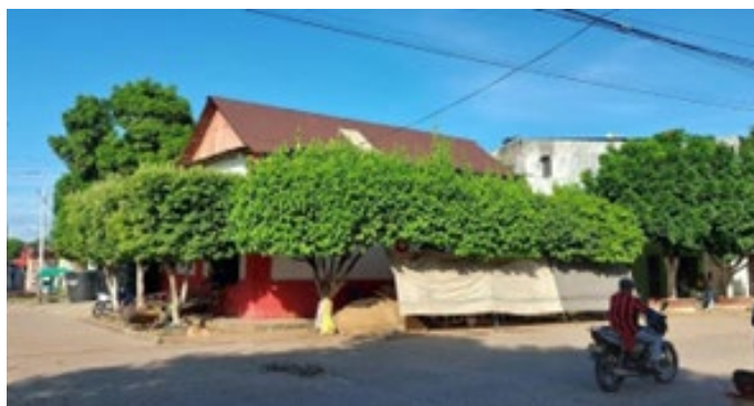
Figura 10. Casa tradicional urbana en mampostería. El Banco. Fuente: Elaboración de los autores.
