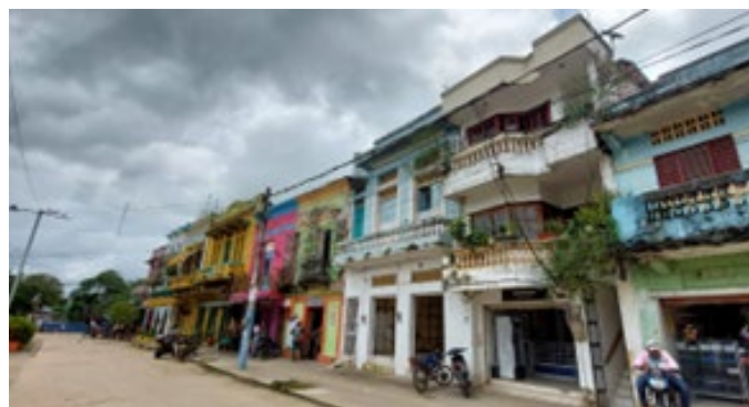
Figura 11. Casas urbanas en mampostería, Sucre. Fuente: Elaboración de los autores.
