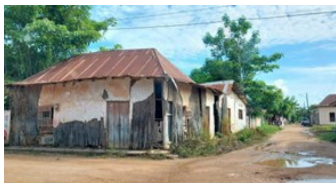
Figura 13. Casa tradicional urbana entramado en nepa de corozo, Santiago Apostol. Fuente: Elaboración de los autores.
