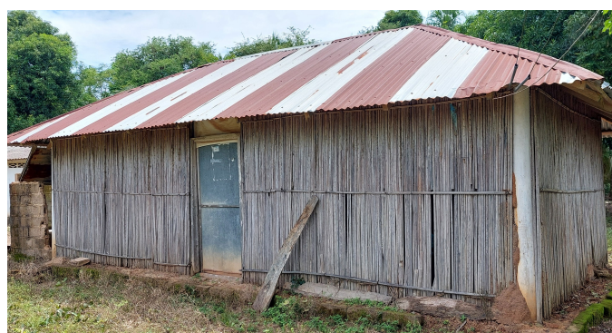
Figura 15. Casa tradicional en la ciénaga en nepa de corozo, San Marcos. Fuente: Elaboración de los autores
