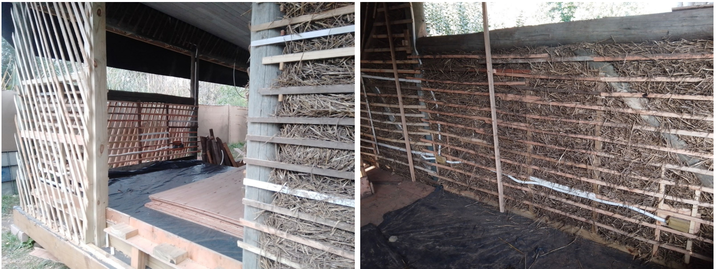
Figura 3: Proceso constructivo vivienda Escobar. Fuente: Elaboración de los autores.
