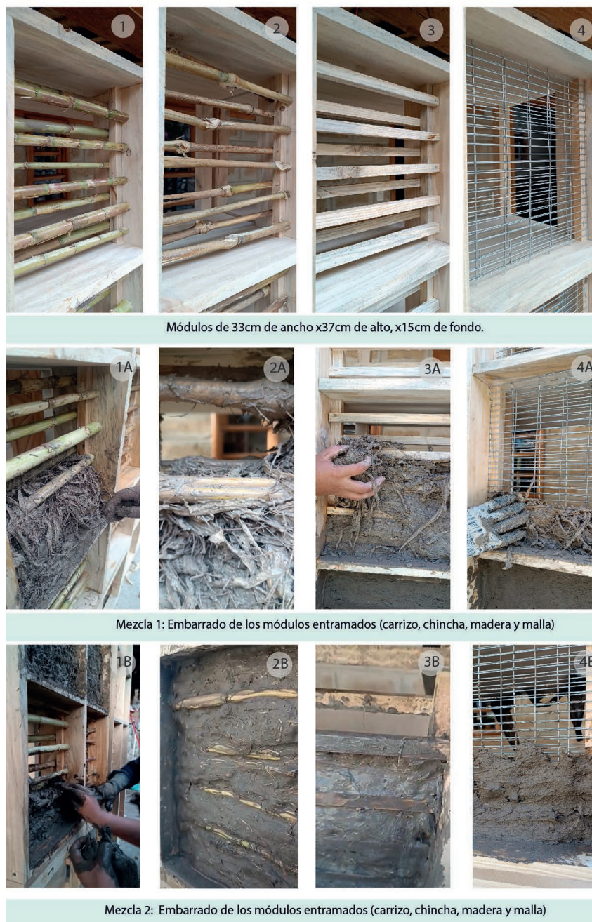
Figura 2. (a) Planta y elevación del muestrario de entramado. (b) Preparación de la mezcla dosificada. (3) Aplicación de la mezcla en los entramados de carrizo, chinchá, madera y malla. Fuente: Elaboración de los Autores.
