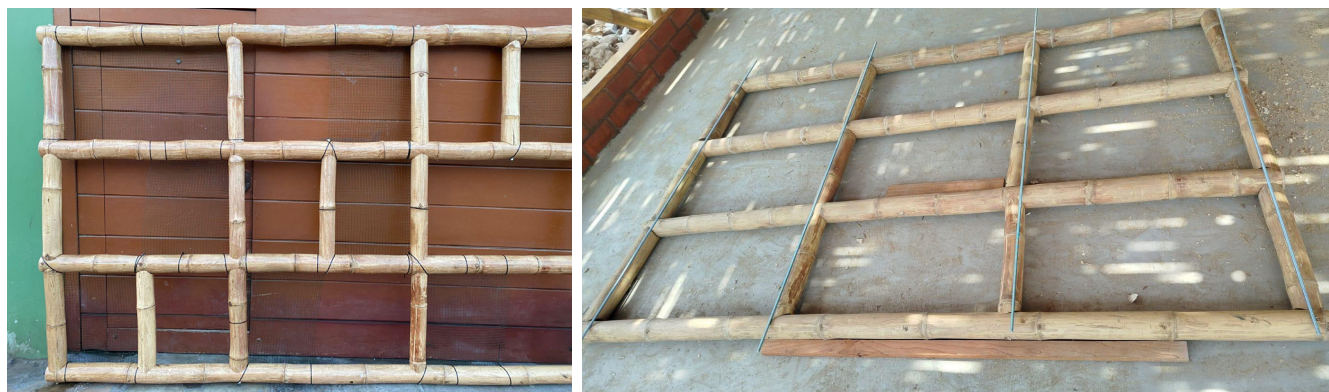
Figura 6. Ensamblaje del sistema estructural de bambú. Fuente: Elaboración de los autores.
