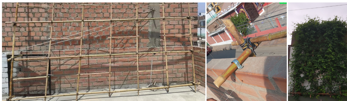
Figura 7. Ensamblaje del sistema estructural del bambucillo e instalación al muro. Fuente: Elaboración de los autores.
