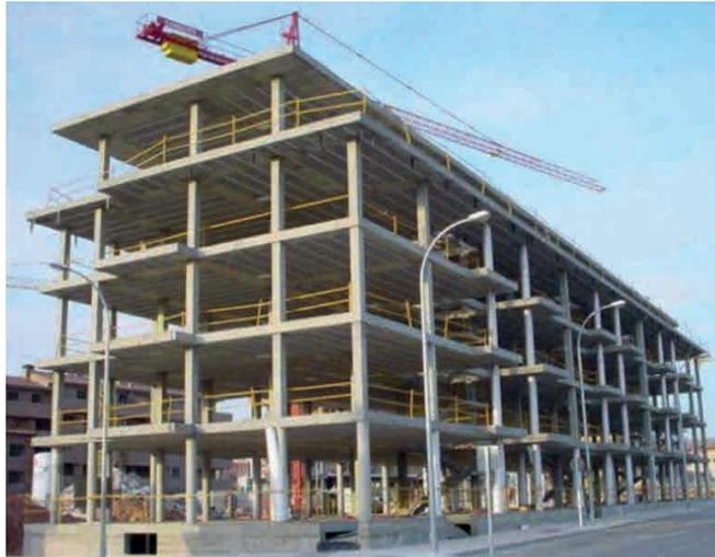
Figura 4. Ejemplo de estructura de forjado reticular
