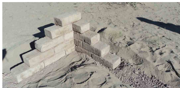
Figura 2. Aparejo de sogas del adobe. Fuente: Elaboración propia. Febrero 2013.
