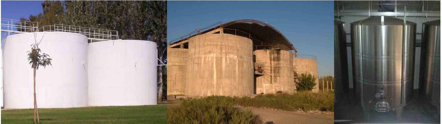
Figura 4: EV de acero común, caso 5 (MI).
