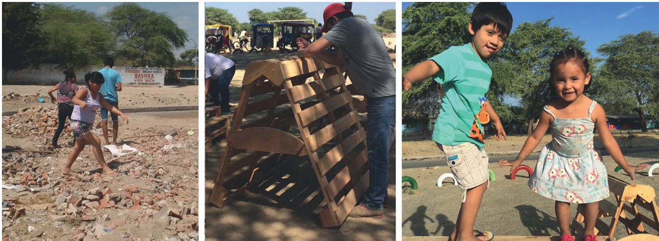
Figura 5. Parte del proceso de ejecución del Parque Santa Julia. Fuente: Fotografías de las autoras.
