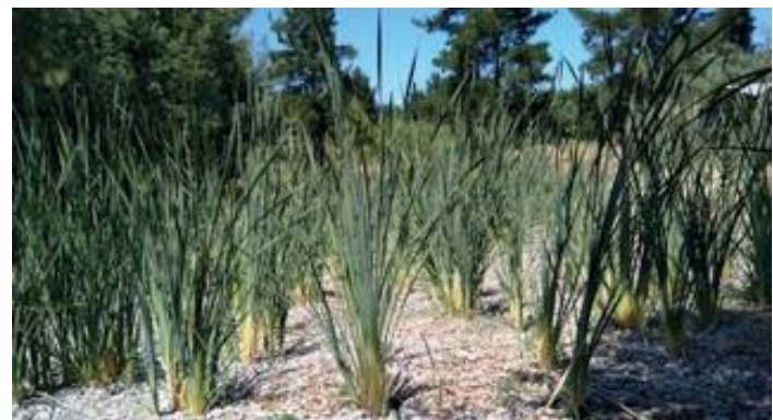
Figura 4. Humedal de flujo subsuperficial con crecimiento controlado y acotado de espadañas. Fuente: Elaboración de los autores.
