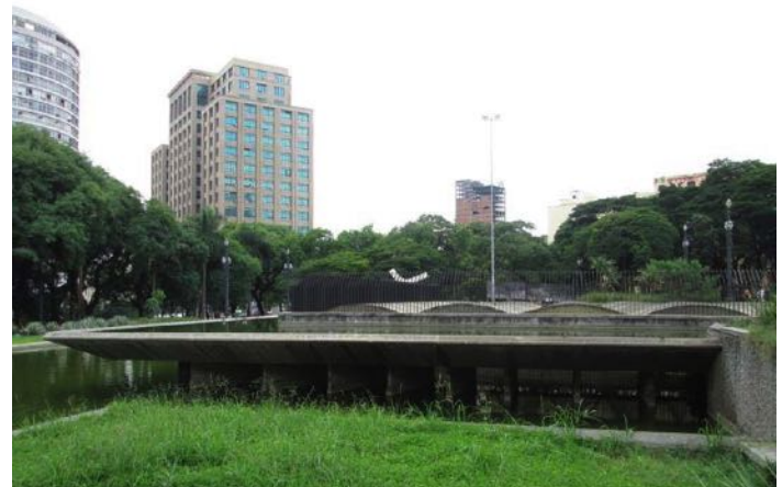
Figura 7. Vinculación entre Praça da Sé y estación Sé. Fuente: Fotografía del autor.
