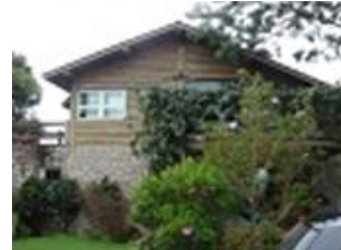
Residência 03, EMPRESA B
