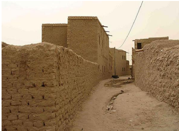
Figura 2: Marrakech. (Fotografía de Darío Alvares. http://arquitecturas.files.wordpress.com/2009/08/tombuctu.jpg )
