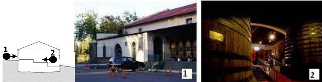
**Figura 4:** Esquema del edificio tradicional en el que se indican la ubicación de las fotografías, desde afuera y desde adentro, en donde se puede apreciar la diferencia de niveles del piso que potencia la pendiente natural del terreno. Fuente: Ganem, C., 2012.
