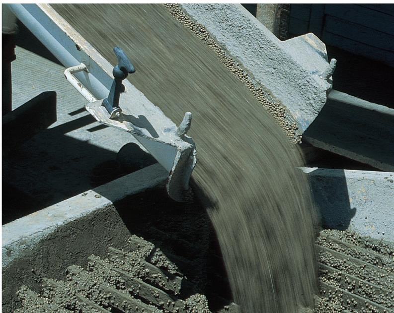
Fig. 3 Hormigón premezclado con alta fluidez.
