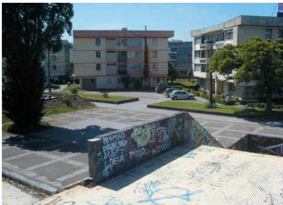
Remodelación Paicaví, (1965). CORVI; TAU: S. González, G. Mardones, J. Mardones, J. Poblete y P. Iribarne. Fte.: Archivo P. Fuentes
