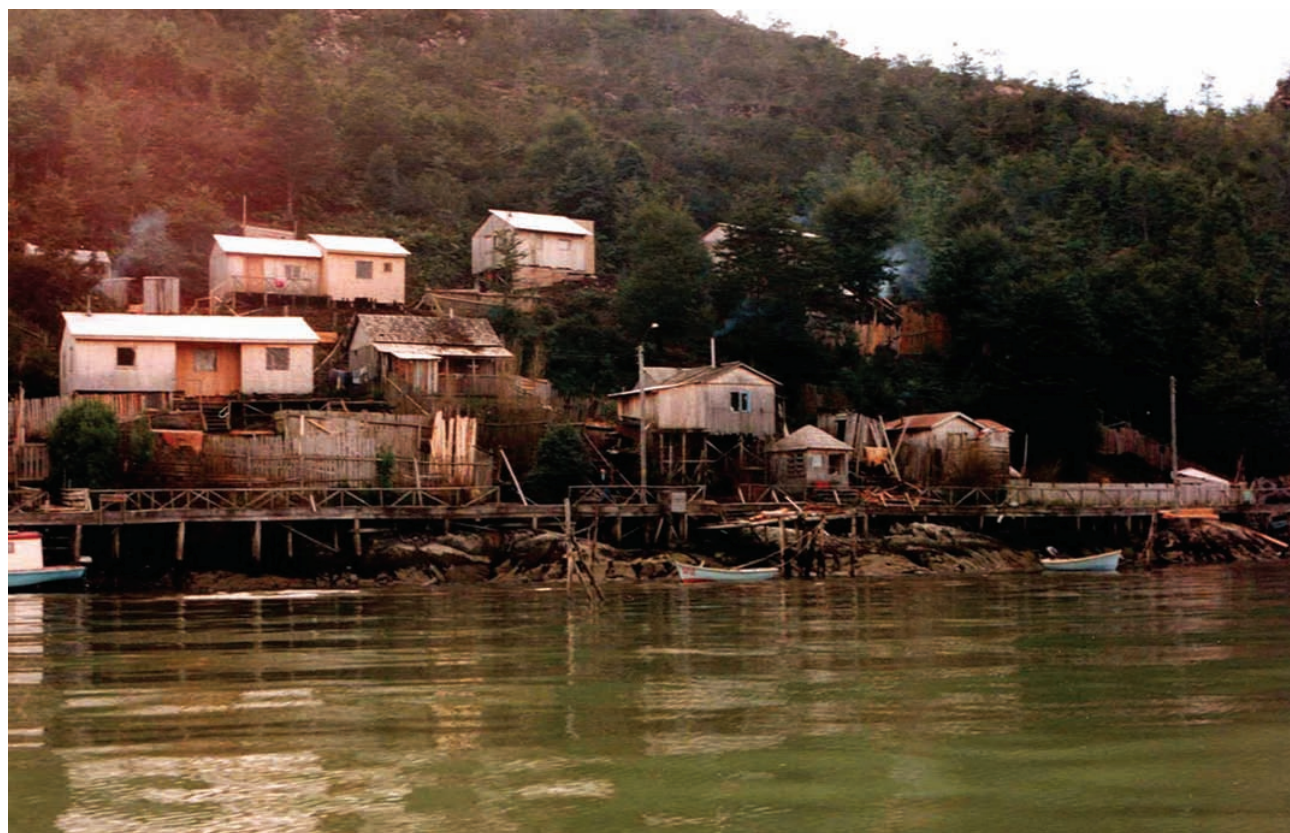
Figura 09: Caleta Tortel en la Undécima Región. Se pueden apreciar las pasarelas de madera en el borde, sobre las rocas y el agua, así como las viviendas sobre pilotes y algunos maderos acopiados en la orilla. Imagen del autor. 2000
