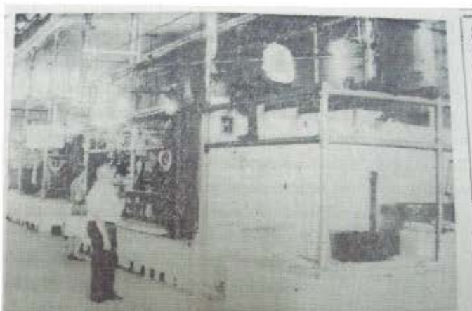
En plena demolición, y al lado, una de las últimas clientas realiza sus compras. El panorama de esta mañana en el ya ex Mercado Central
