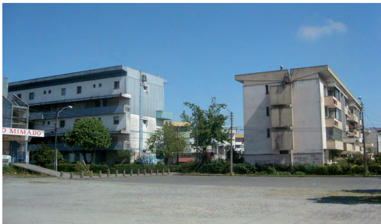
Fig. 3. TAU, Mardones, Mardones, Poblete, Iribarne, González - CORVI. Remodelación Paicaví (1965). Arch. PFH.
