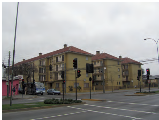
Fig. 2. Conjunto Carrera esq. Pelantaro. Arch. PFH.
