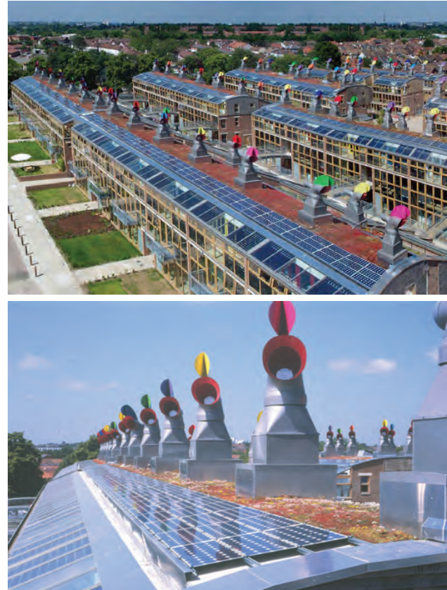
Figura 7: BedZED, vista de áreas residenciales y de trabajo. Detalle cubiertas. Fuente: www.arup.com/_assets/_download/download68.pdf
