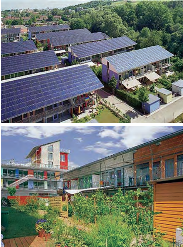
Figura 6: Comunidad de casas solares Friburgo Alemania, arquitecto Rolf Disch. Fuente: http://www.domoking.com/2008/01/12/comunidad-de-casas-solares-por-rolf-disch/
