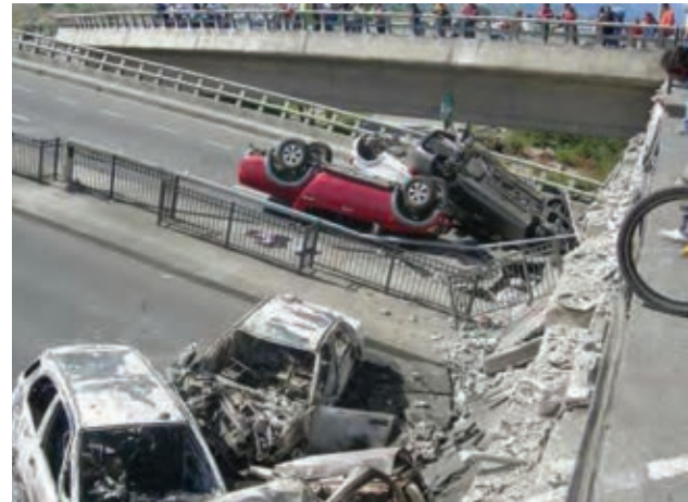
Fig. 3 Colapso Puente Llacolén
