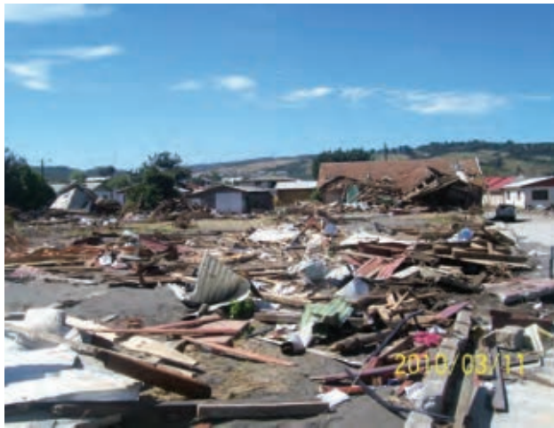
Fig. 29 Zona de borde fluvial mayormente afectada por el tsunami en tirúa frente a la costanera
