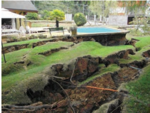
Fig. 11 Agrietamientos, asentamientos y desplazamientos laterales en bordes fluviales (camino a Santa Juana)
