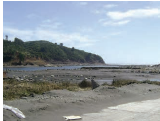
Fig. 30 Desembocadura del río Tirúa. El tsunami destruyó el muro de defensa fluvial
