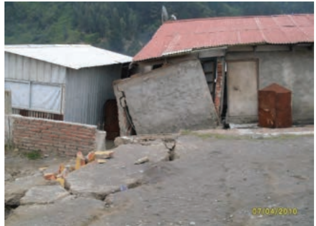
Fig. 14 Hundimientos de rellenos sobre terrenos de humedal en Lengua
