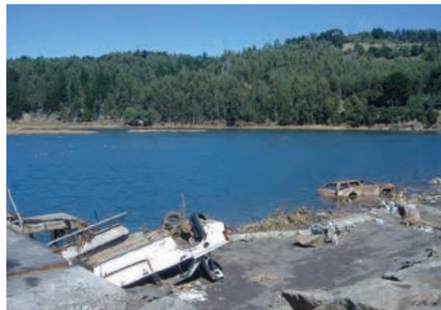
Fig. 33 Calle costanera de Tirúa arrasada por tsunami. Aquí se emplazaba la municipalidad
