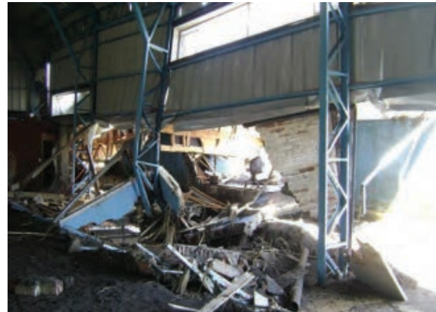
Fig. 32 Gimnasio municipal de Tirúa emplazado frente a la costanera del río
