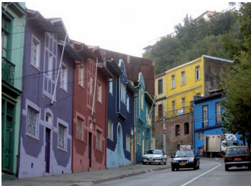
Arquitectura en el singular contexto topográfico de Valparaíso, donde se expresa parte importante del patrimonio construido de la ciudad.
