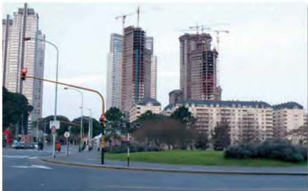
Docks y Torres en construcción en el barrio Puerto Madero. Foto SD
