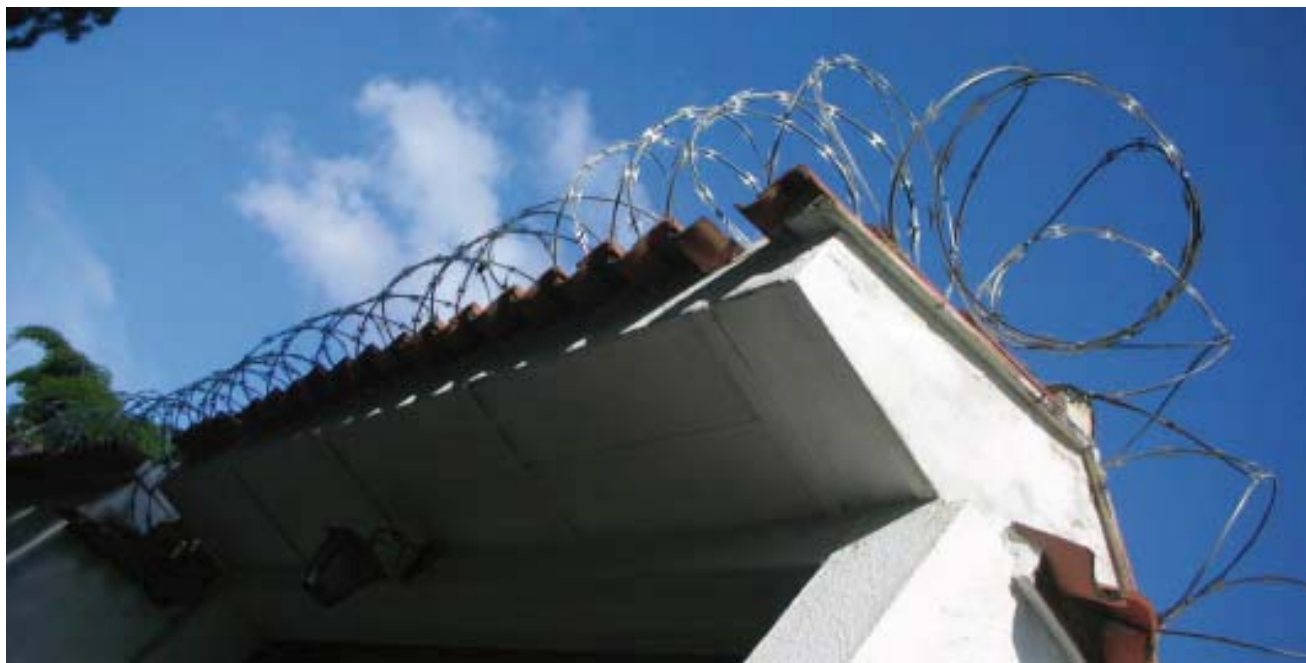
Espacio cerrado con fuertes dispositivos de seguridad físicos y electrónicos, verdaderos bunkers urbanos, actuales símbolos de protección ciudadana, que “agreden” y distancian la ciudad exterior.
