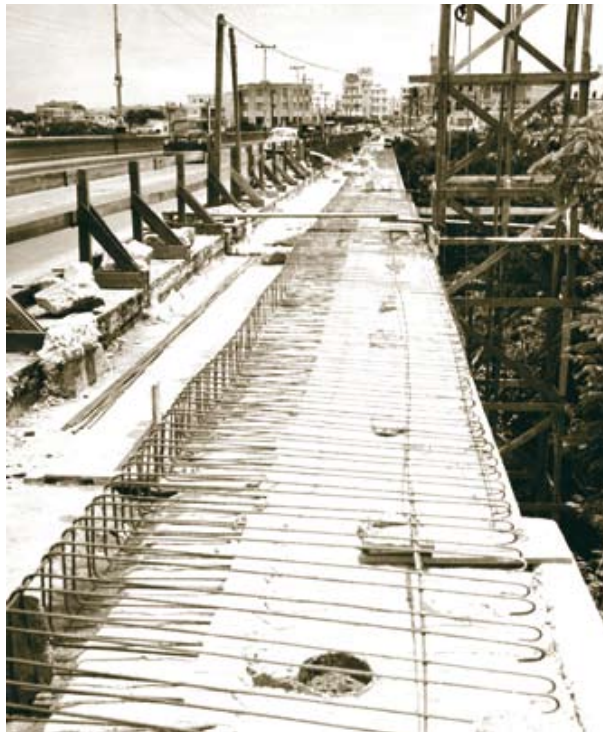
Ampliación del ancho del puente sobre el río Almendares
