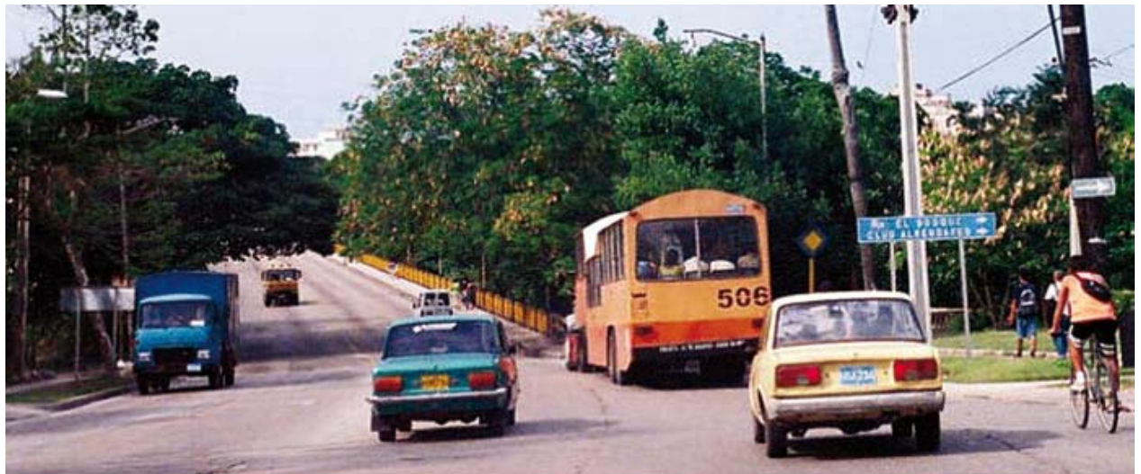
Calle 26 y puente Almendares sobre el río homónimo.
