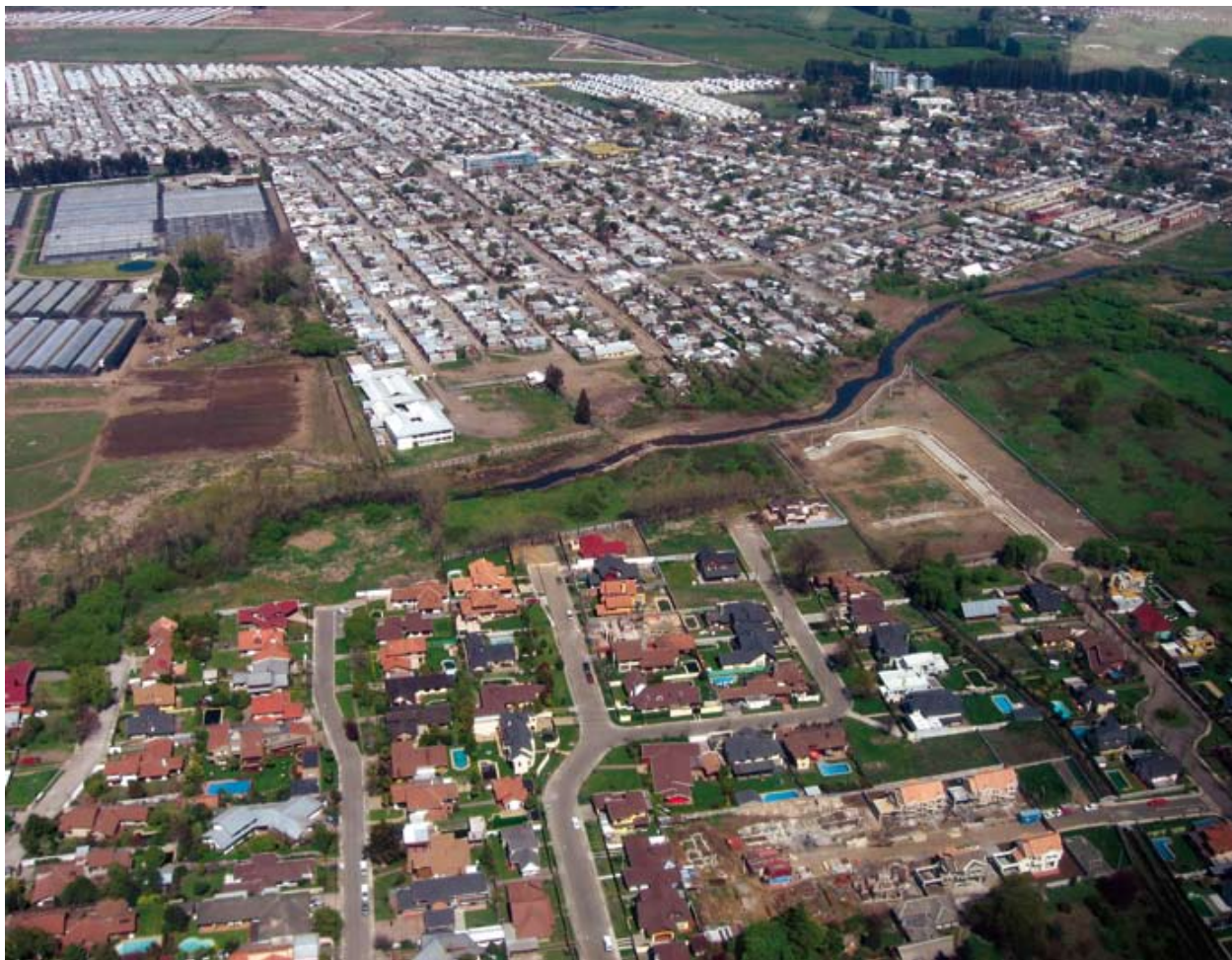
El Estero Paillihue como elemento de división de un barrio de estándar medio y sectores de alta densidad del sur de la ciudad.
