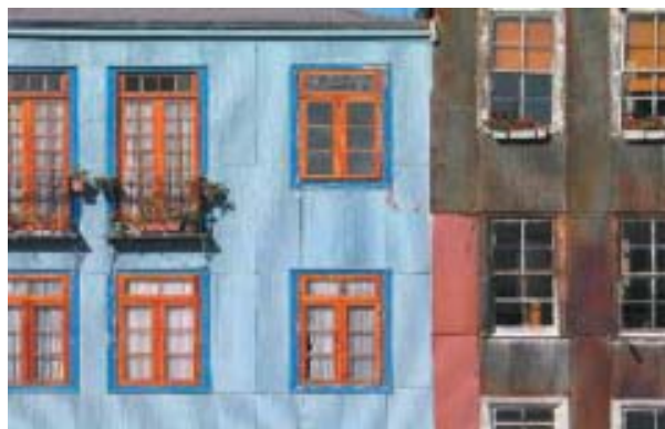
Barrios: instantánea de fachadas habitacionales en los cerros porteños.
