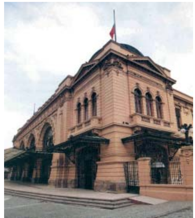
Estación Mapocho. Inaugurada en 1912, obra del arquitecto Emilio Jecquier. Se convirtió en la puerta de entrada internacional de Santiago.
