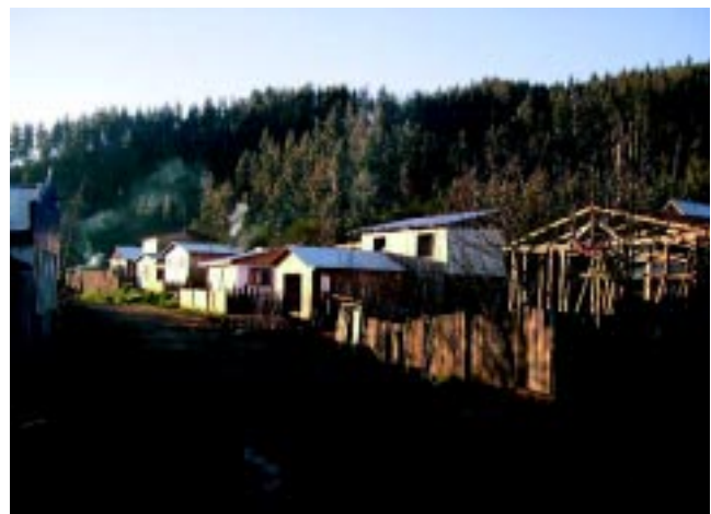
Casas de la provincia de Arauco, en construcción de madera y techos de zinc.
