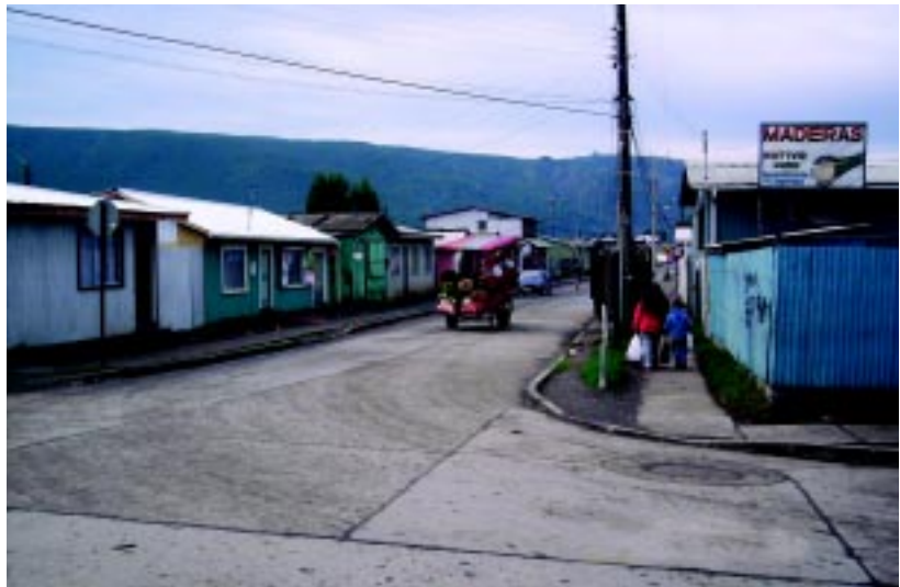
Dos imágenes que grafican una visión urbana característica en todas las ciudades y pueblos de la provincia de Arauco, con una vialidad reconocible y construcciones de materialidad constante.
