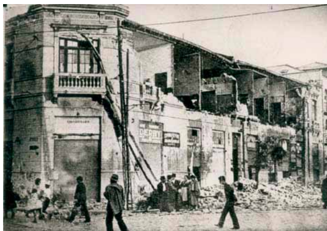
Efectos del terremoto del año 1939 en Chillán, lo que permite la reconstrucción continua de la ciudad.
