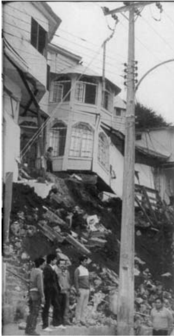
Ejemplo de edificación en área de riesgo natural.
