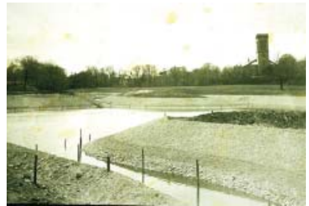
El Muddy River Bajo Construcción, Boston.
