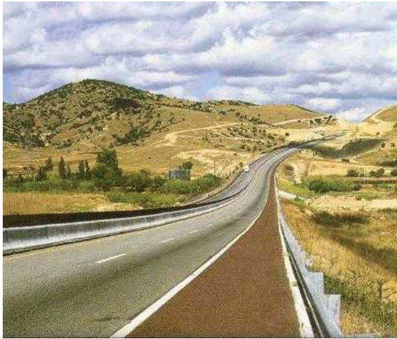
Autopista en situación de bajo uso.
