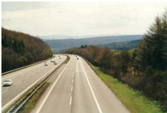
Autopista en situación de uso medio.
